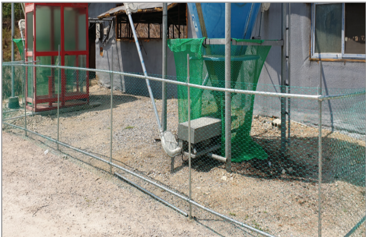
〈간소화 사례 : 기둥 및 그물망 설치〉
