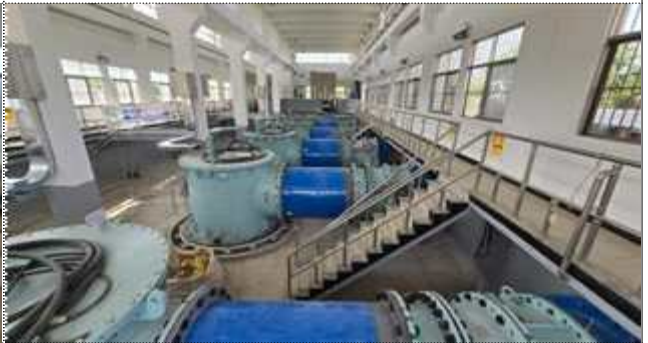
배수장 기계(펌프) 교체
