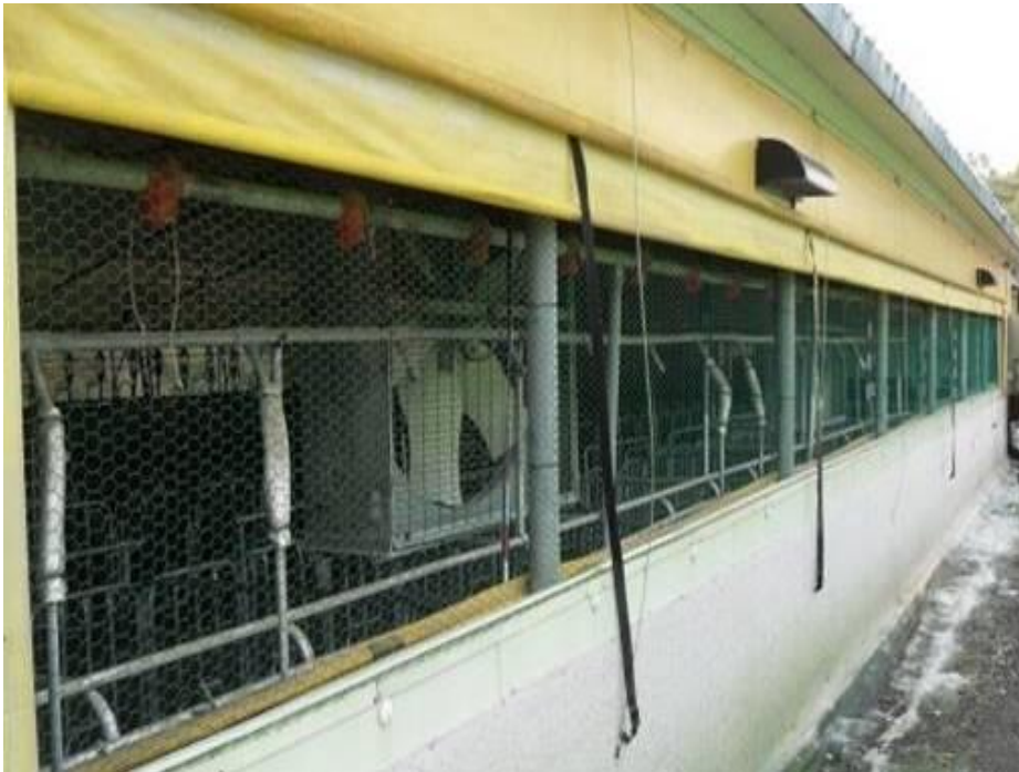
축사 벽면 방조망 설치
