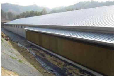
< 육계사 쿨링패드 설치 >
